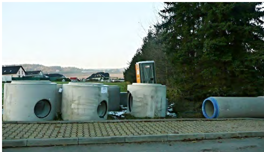
Budování kanalizace v ul. Sadová. Více o akci v rozhovoru s ředitelkou SMJ Miroslavou Tichou.
