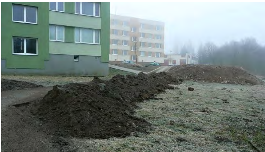
Terénní úpravy na sídlišti Zborovská.
