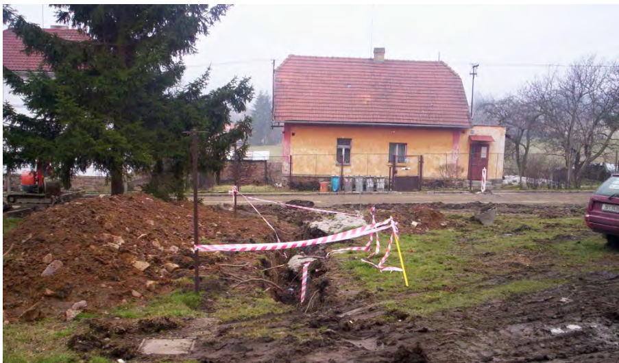
Městys Jince zahájil rekonstrukci ulice Čsl. dělostřelců spojenou s výstavbou nového chodníku, parkovacích ploch, veřejného osvětlení a zeleně.
