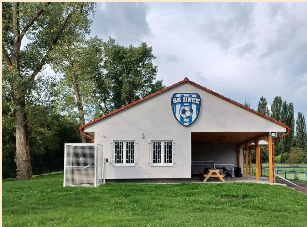
Přístavba zázemí fotbalového hřiště v Jincích
