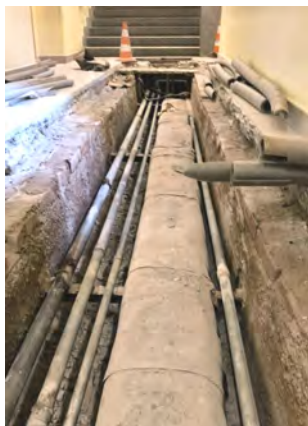
Základní škola - výměna potrubí v kolektoru
