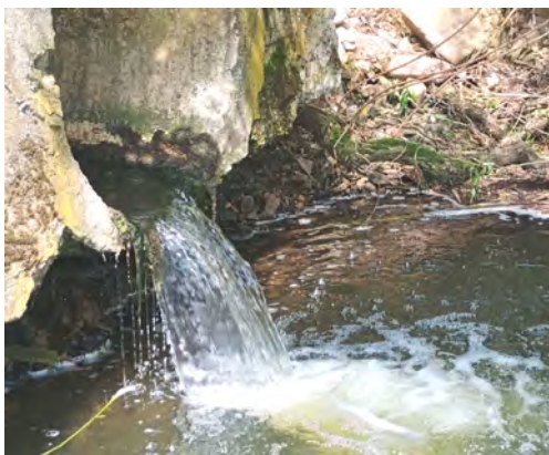
Vyčištěná voda vypouštěná do Litavky
