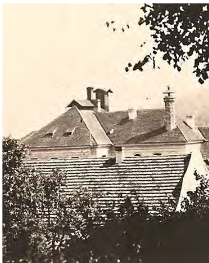
Střecha bývalého zámku. V popředí dům u Patschů, který stával na parkovišti u kovářny ještě v 50. letech minulého století. Roku 1876 v něm byly zřízeny dvě školní místnosti.
